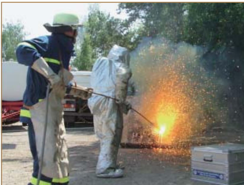
Décomposition spectaculaire d'une plaque de béton par les professionnels du THW. Spektakulär ist das Durchtrennen eines Betonblocks durch Leute des THW.
