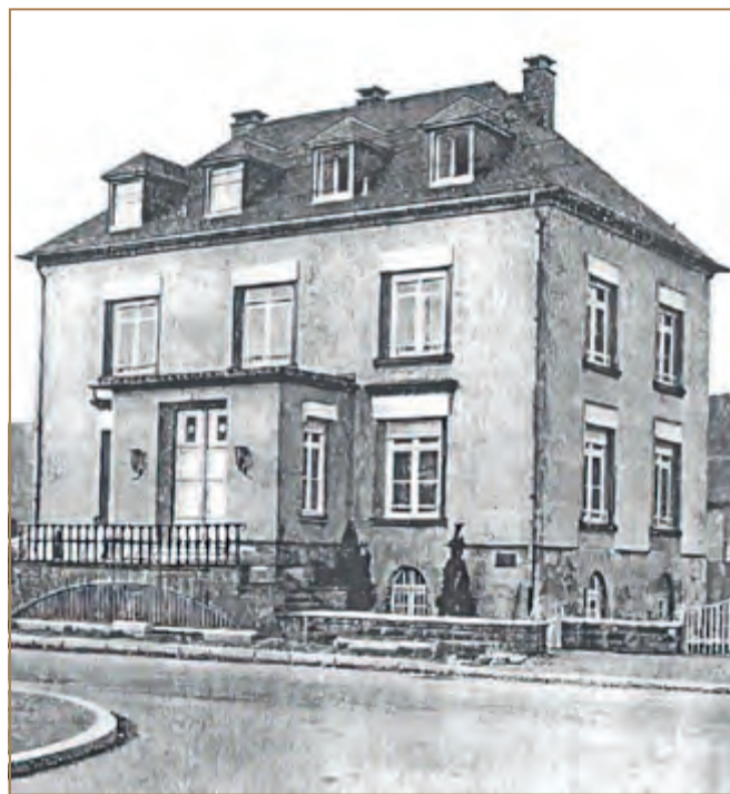
Witry-Haus (géint 1850 gebaut) – Foto: Broschür Fanfare1958
