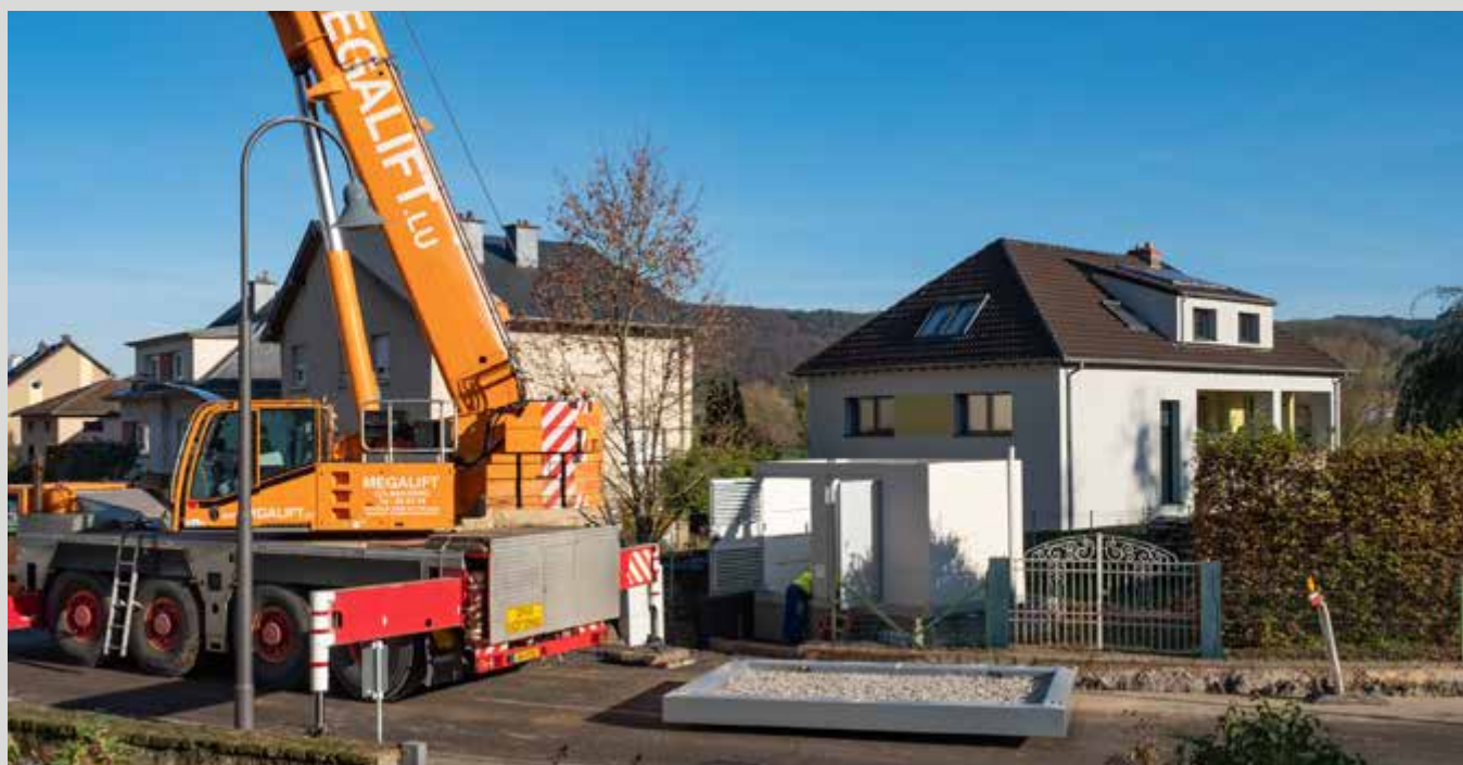
Chantier Goussel - (Foto: Dan Schmit)
